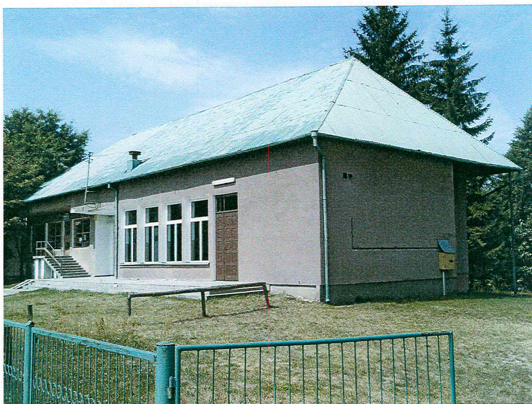
Budynek do remontu z przeznaczeniem na centrum społeczno - kulturalne
