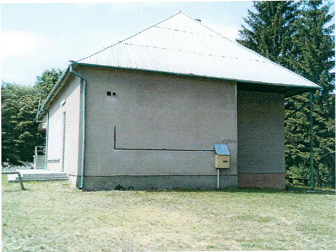
Budynek do remontu z przeznaczeniem na centrum społeczno - kulturalne
